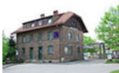
Bahnhofsgelände: Bahnhof Taufkirchen-Unterhaching, Blankziegelbau, um 1900, Am Bahnsteig 1
