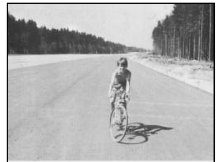
Die neue B13 im Bau im Jahr 1970.
