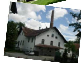
Früher gab es noch zwei weitere Baudenkmäler: Ehemaliger Bauernhof „ Beim Sattler “, Münchener Str. 41, und die Genossenschafts- brennerei , Tölzer Str. 1
